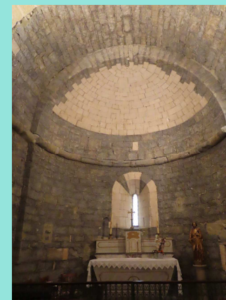
Vue intérieure du chœur d'origine.
